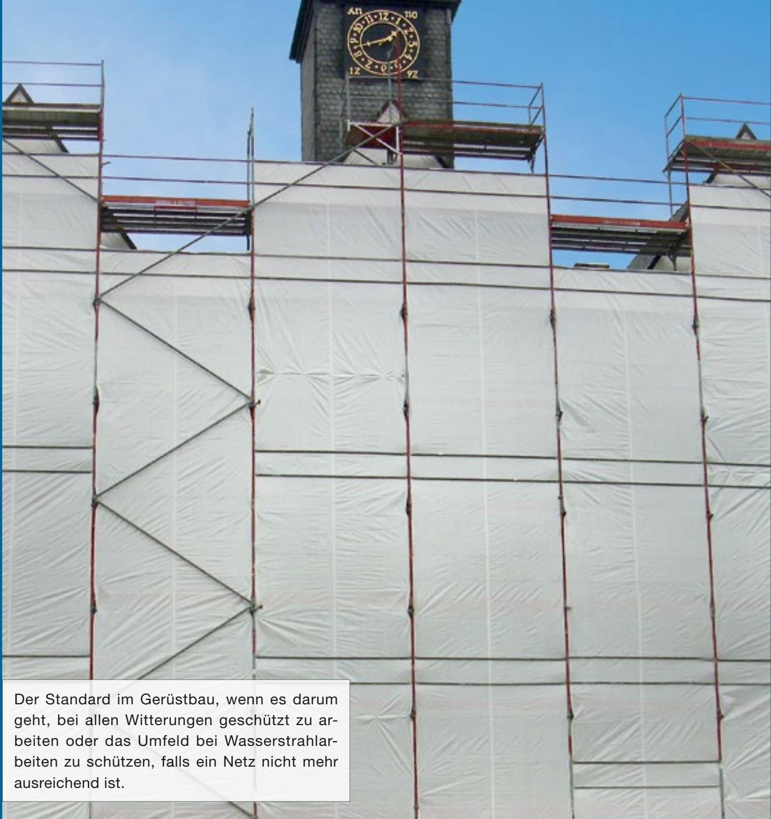
Der Standard im Gerüstbau, wenn es darum geht, bei allen Witterungen geschützt zu arbeiten oder das Umfeld bei Wasserstrahlarbeiten zu schützen, falls ein Netz nicht mehr ausreichend ist.
