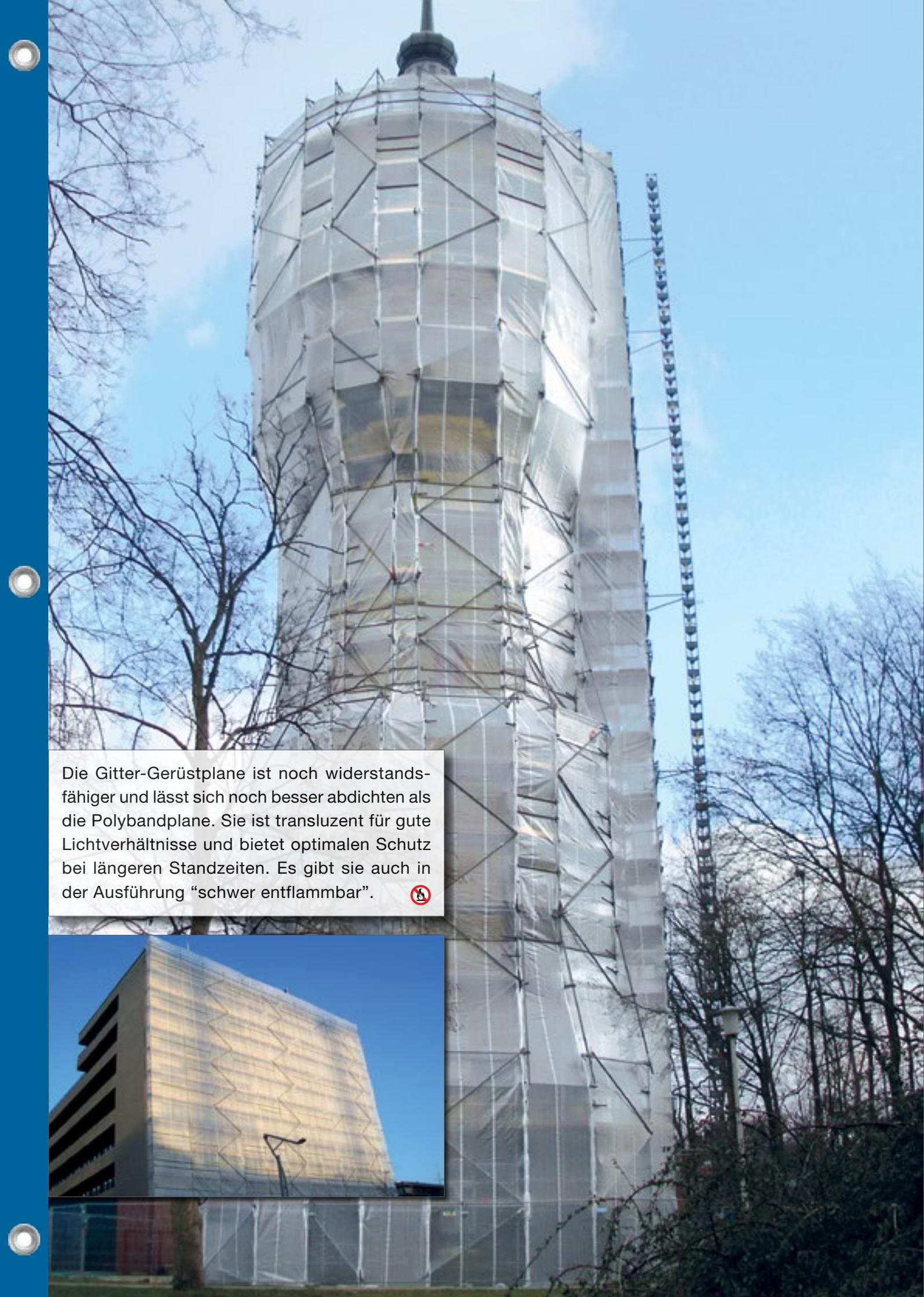
Die Gitter-Gerüstplane ist noch widerstandsfähiger und lässt sich noch besser abdichten als die Polybandplane. Sie ist transluzent für gute Lichtverhältnisse und bietet optimalen Schutz bei längeren Standzeiten. Es gibt sie auch in der Ausführung "schwer entflammbar".
