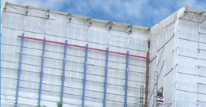
Kederplanen aus PVC-beschichtetem Trägergewebe ermöglichen eine wasser- und staubdichte Einhausung von Arbeitsplätzen, z. B. für Sandstrahlarbeiten beim Korrosionsschutz. So werden Umweltbelastungen sicher vermieden.
