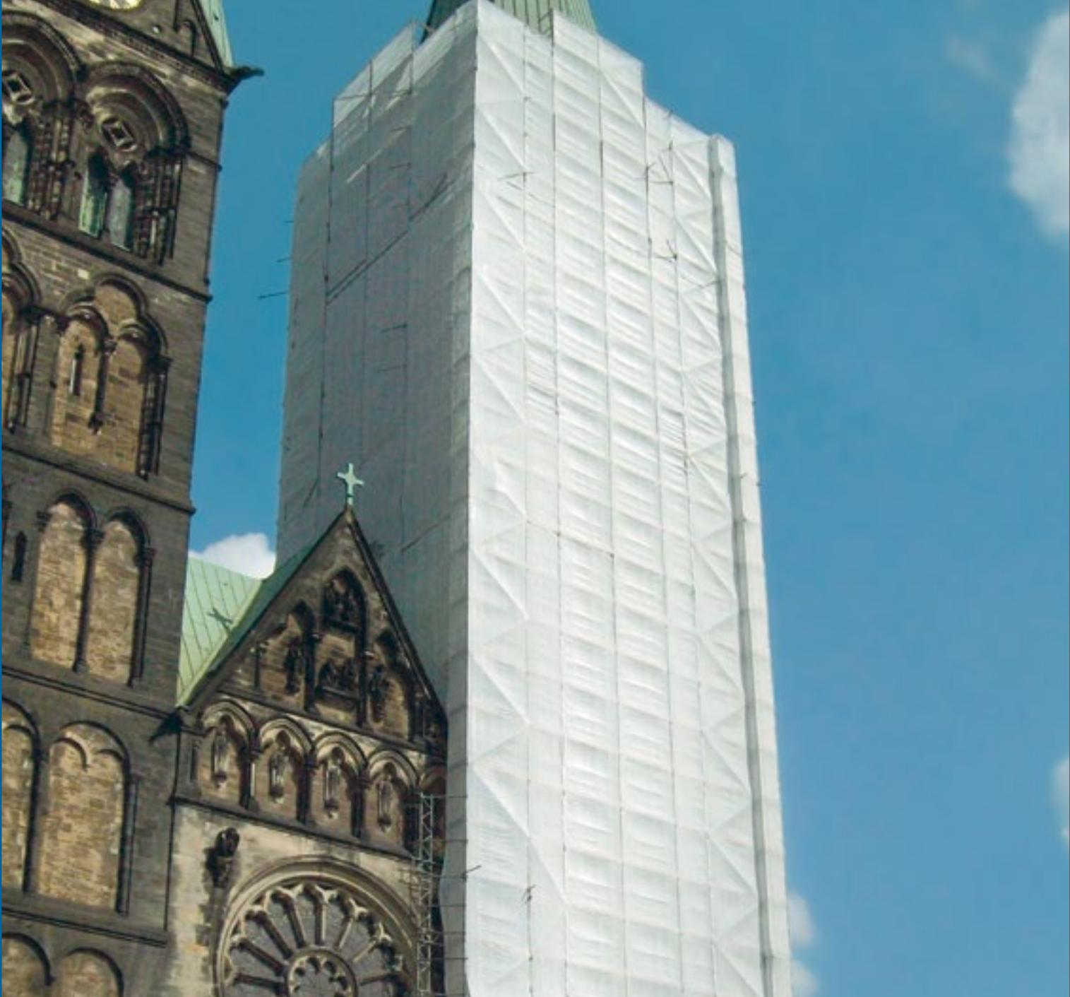
Dieses schwere Gerüstschutznetz ist wiederverwendbar. Es bietet optimalen Witterungsschutz, ist staubdicht, dabei aber luftdurchlässig. Auch eine schwer entflammable Ausführung ist erhältlich.
