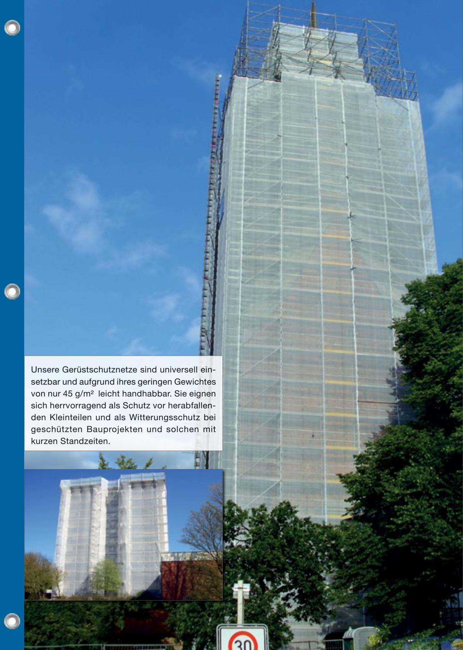
Unsere Gerüstschutznetze sind universell einsetzbar und aufgrund ihres geringen Gewichtes von nur 45 g/m<sup>2</sup> leicht handhabbar. Sie eignen sich hervorragend als Schutz vor herabfallenden Kleinteilen und als Witterungsschutz bei geschützten Bauprojekten und solchen mit kurzen Standzeiten.
