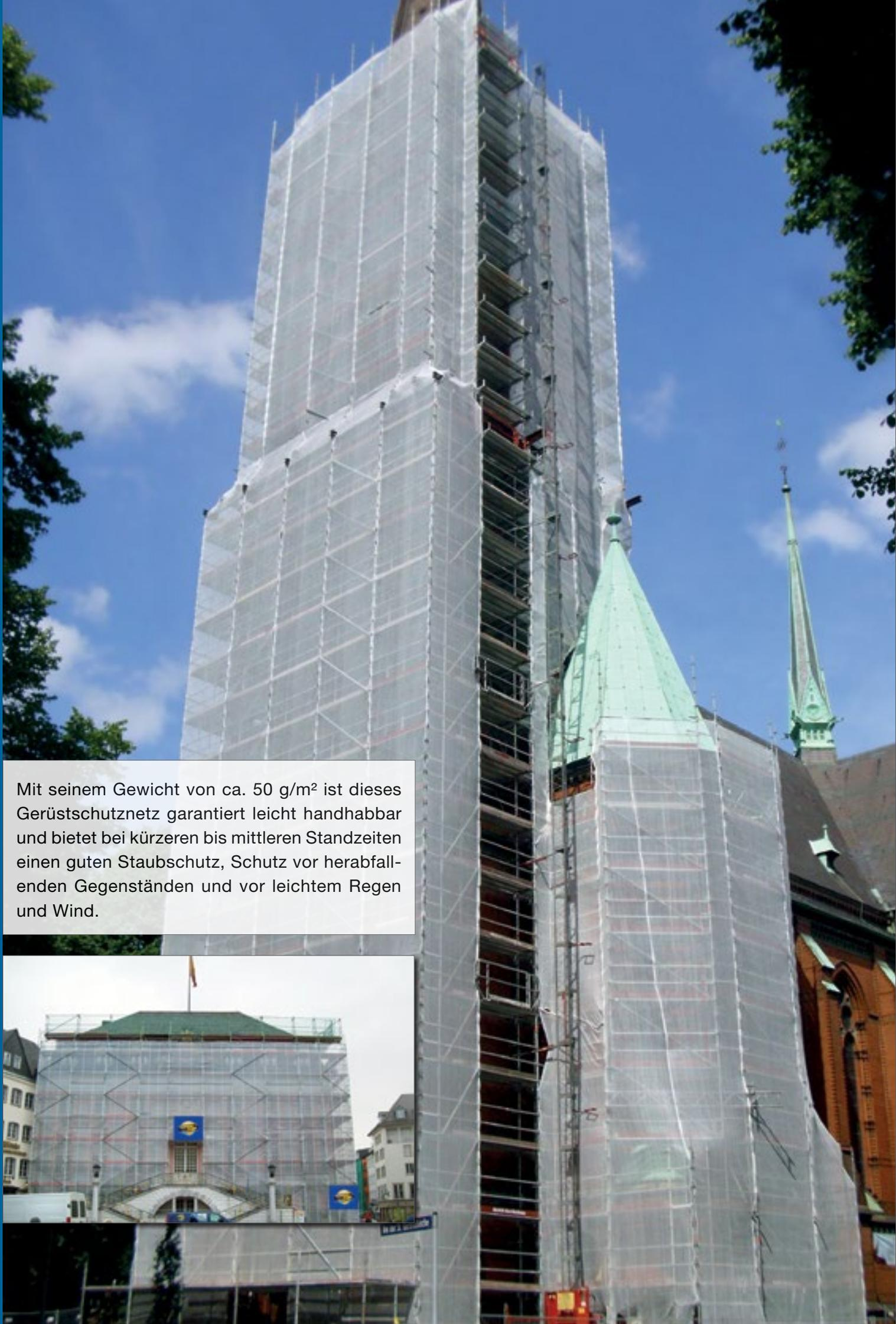
Mit seinem Gewicht von ca. 50 g/m<sup>2</sup> ist dieses Gerüstschutznetz garantiert leicht handhabbar und bietet bei kürzeren bis mittleren Standzeiten einen guten Staubschutz, Schutz vor herabfallenden Gegenständen und vor leichtem Regen und Wind.
